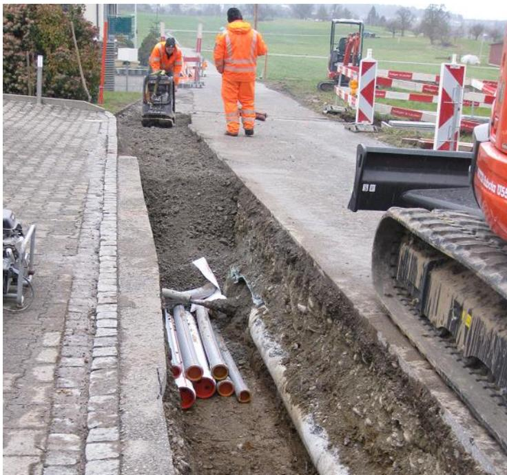
Gleichzeitig werden auch die Werkleitungen in der Weihermattstrasse erneuert, die alten, korrosionsanfälligen Leitungen durch dauerhafteres Material ersetzt.
