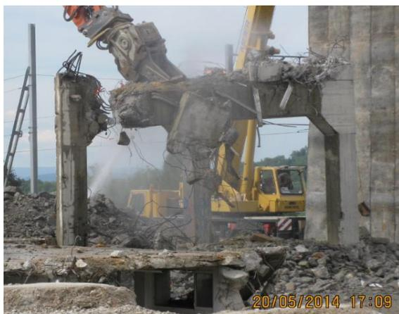
Unterbau des Silos wird eingerissen
