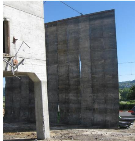
Zum Schutz von SBB-Fahrleitung und Strasse wird eine Wand hochgezogen.
