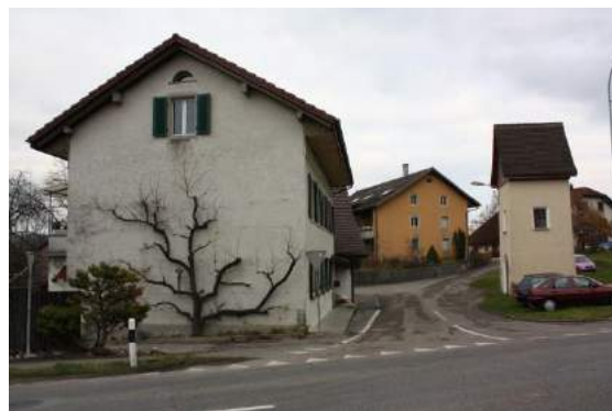
Eingang Seengerstrasse mit Altem Schulhaus und noch in Betrieb befindliches Trafoshaus
