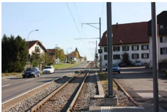
Statthalterhaus, Mitteldorf 49, mit ortsbaulich prägender Stellung im Strassenraum
